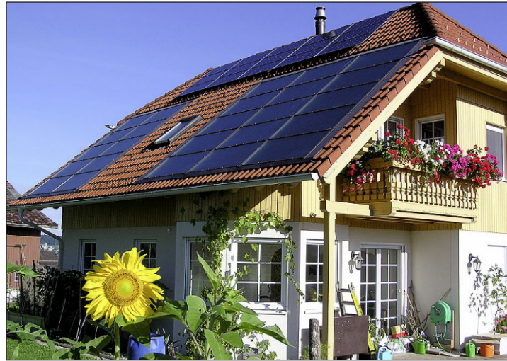
Sonnenhaus mit Sonnenblume: Solartechnologie verträgt sich auch mit rustikalen Bauten wie diesem Einfamilienhaus im Toggenburg.
